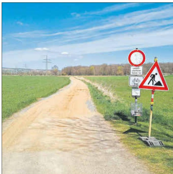
Erst am Dienstag nach Ostern konnten die Sanierungsarbeiten am Fernradweg R6 von der Ziegelhütte nach Kirchhain mit dem Auftragen und dem Einbau einer Feinschicht abgeschlossen werden. Deshalb profi-
