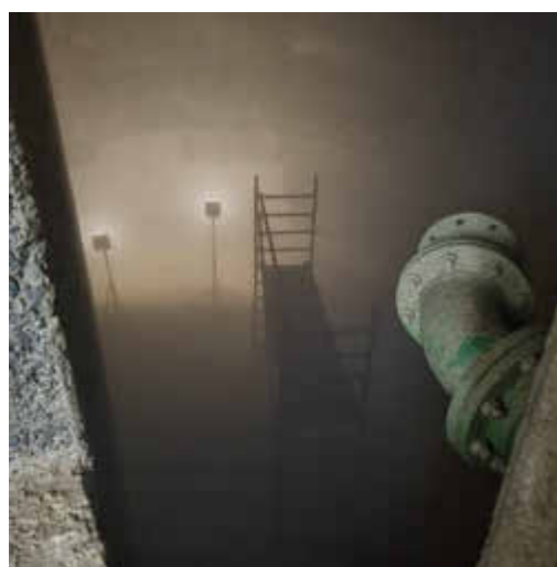
Bild: Das Bild zeigt eine der beiden 650cbm großen Behälterkammern des Hochbehälters in Roßdorf während der aktuellen Betonsanierung
